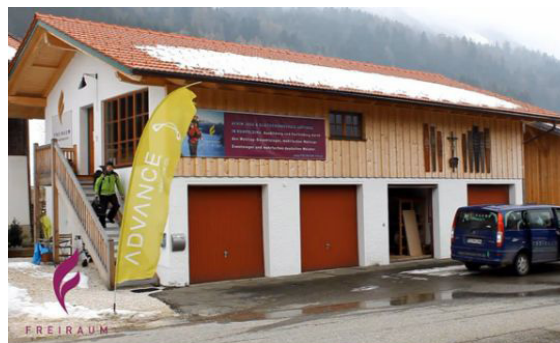
FLUGSCHULGEBÄUDE IN RUHPOLDING
